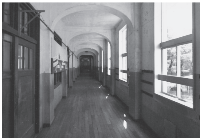
強固なアーチ状の梁の廊下
