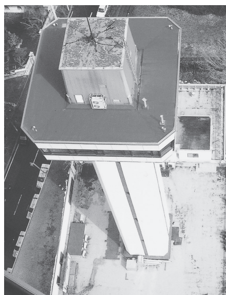
新タワーからみた旧タワー
