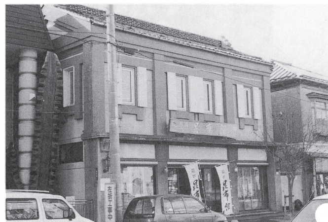
保存建築物 箱館昆布館（函館市末広町）
