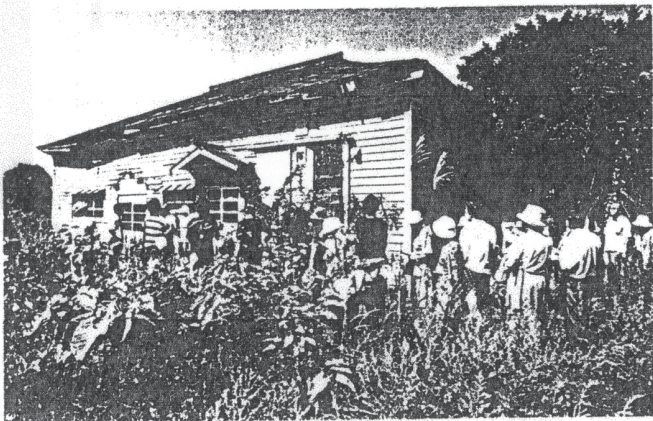
↑③C 港口の丘に建ち解体で現部分を残し荒廃が進む
