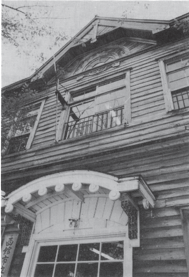
写真② 〈中央玄関と小屋根〉
